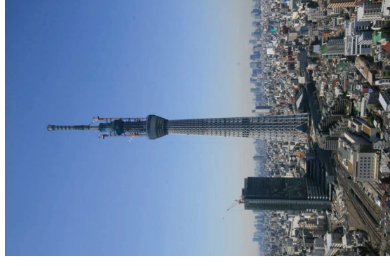
定点写真 平成23年4月20日 撮影
