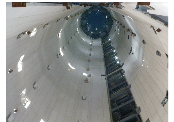
ゲイン塔を組立てる空間
