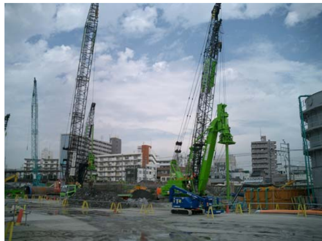
アースドリル杭工事
